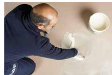
La préparation minutieuse des supports est cruciale pour garantir le succès de la pose de sols souples. Une étape normée qui demande de la précision et exige certains préalables incontournables, comme le ponçage du support, le traitement des fissures, le lissage de la surface ou encore la mesure du taux d'humidité du support. Explications.
