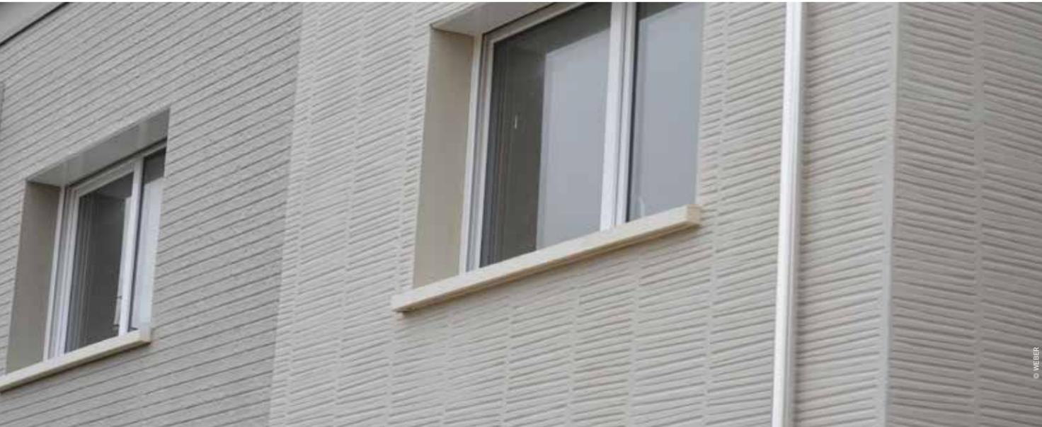
Révélés par des procédés techniques tel le matriçage, les pochoirs ou l'impression, les enduits, outre leur fonction de protection des façades, sont à même de créer des décors remarquables. Bonne nouvelle, il est tout à fait envisageable de réaliser ce type de décor lors de travaux d'isolation thermique en enduit sur isolant (Etics).
