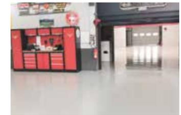
quotidien. Suivant les désirs du client, nous avons posé une peinture époxy grise très clair, avec une couche de finition mate, comparable à un vernis et qui remplit deux fonctions. D'abord éviter les reflets des projecteurs et une brillance un peu trop "bling bling", et protéger la peinture à base de résine des UV qui finiraient par faire virer la teinte dans les verts », observe Alain Brosset. La teinte claire éclaircit et agrandit la pièce.
