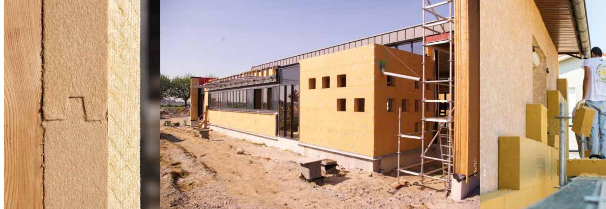
**LA RÉALISATION D'UNE ITE SOUS ENDUIT AVEC DES ISOLANTS BIOSOURCÉS N'EST PLUS À CONSIDÉRER COMME ANECDOTIQUE. LES PRODUITS ET SYSTÈMES, DÉDIÉS À TOUT TYPE DE CONSTRUCTION, SONT AUJOURD'HUI DE QUALITÉ ET TESTÉS SELON LES MÊMES CRITÈRES QUE LES ISOLANTS TRADITIONNELS.**
