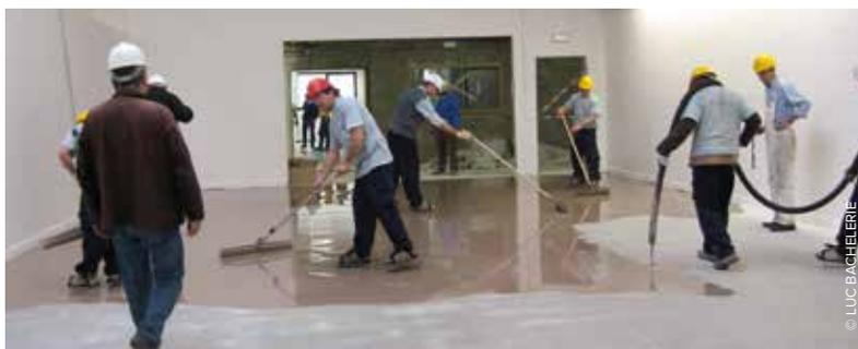
▲ LA MISE EN ŒUVRE DU RAGRÉAGE À AU RÂTEAU D'ÉTALEMENT PERMET LE TRAVAIL DEBOUT.
