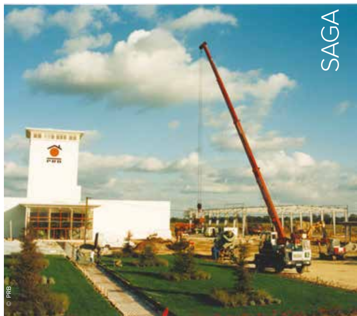
▲ EXTENSION DE L'USINE N°1
