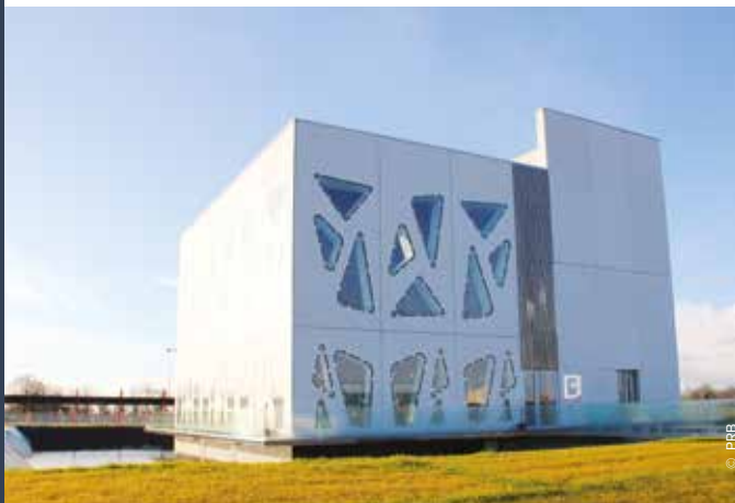
◀ ESPACE JACQUES LAURENT SUR LE SITE PRB DANS LA VILLE DES ACHARDS
